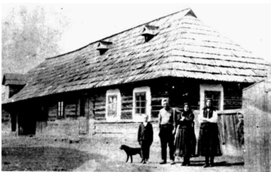
„Gerezdbe épített, dránicával fedett ház”
